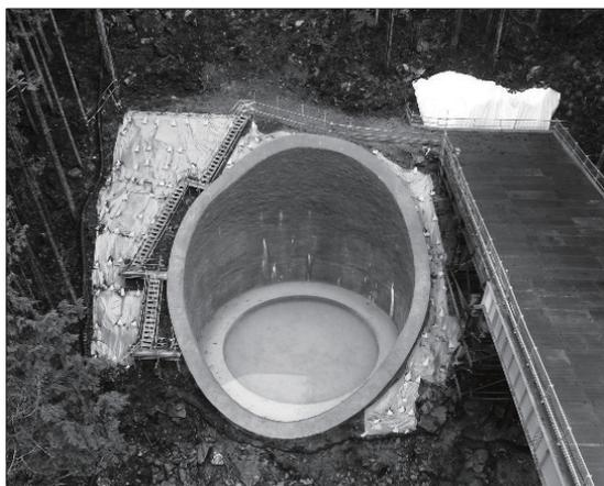
写真-2 竹割り型土留め工 完成写真
