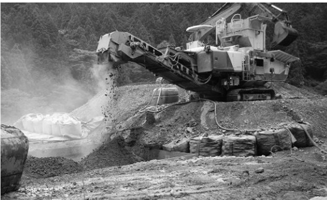
材料の混合(掘削土とセメントを混合)
