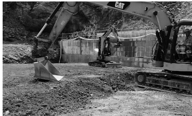
材料の敷き均し
