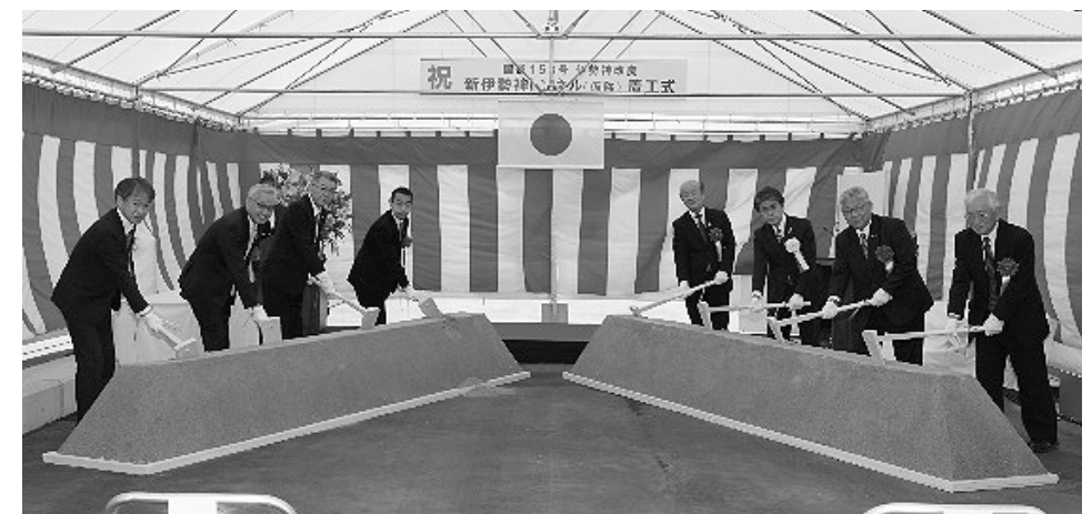
国道153号新伊勢神トンネル(仮称)着工式の様子
