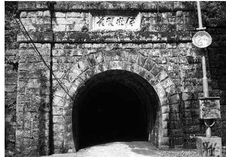
伊世賀美隧道
