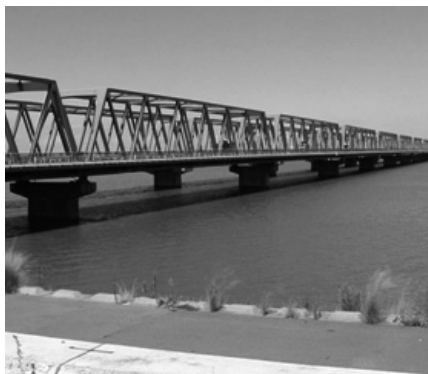
(a)木曽川大橋 1963年架設
