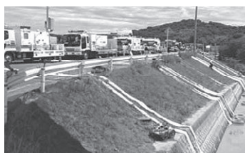
平成30年7月 倉敷市内 排水作業
