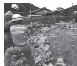
平成30年7月 下呂市内 現地調査
