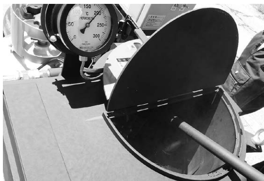
写真-4 材料（シール材）溶解状況
