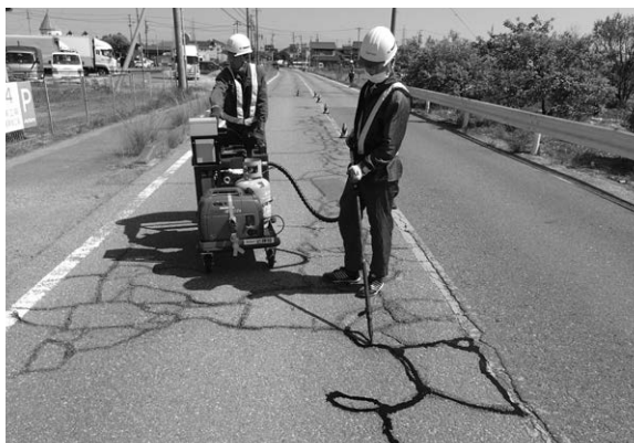
写真-1 舗装クラック注入工法
