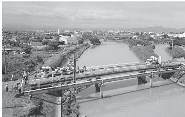
(b)点検状況
