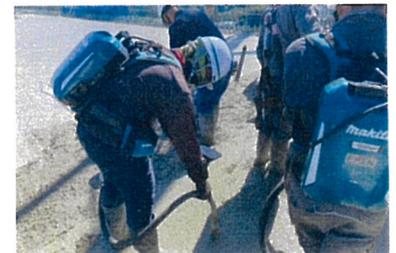
写真-24 コードレスバイブレータ
