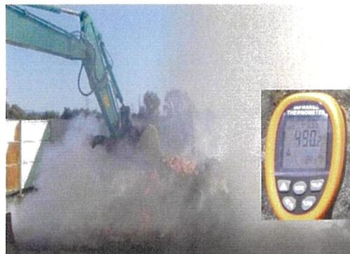
写真-9 : 地面上の焼却作業と焼却温度
