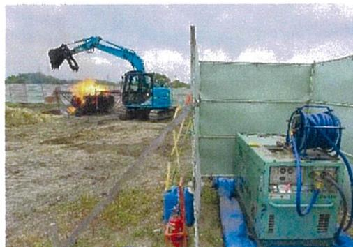
写真-10 : 圧縮空気を供給するコンプレッサー
