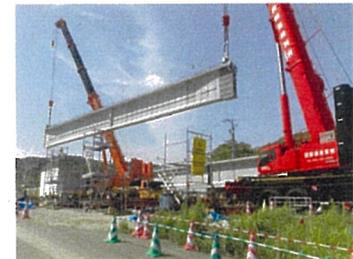
写真-4 架設工
