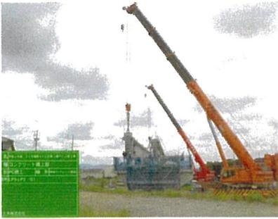
写真-21 実際の主桁架設状況
