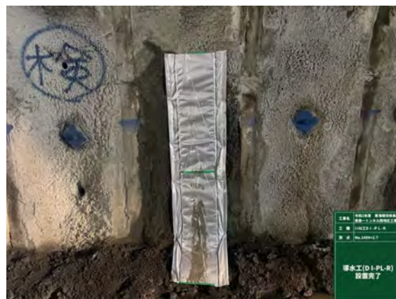
写真－7 導水工施工完了
