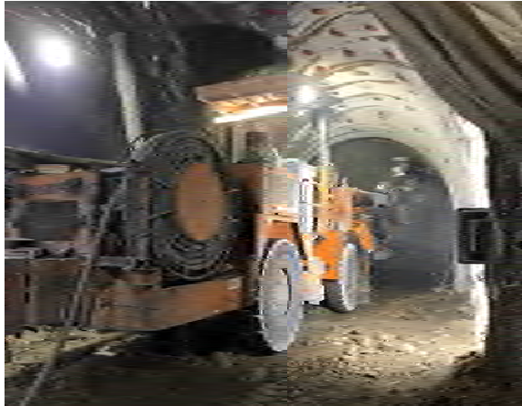
写真-3 避難連絡坑建込み状況
