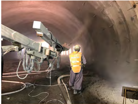
写真－８ 吹付覆工施工状況
