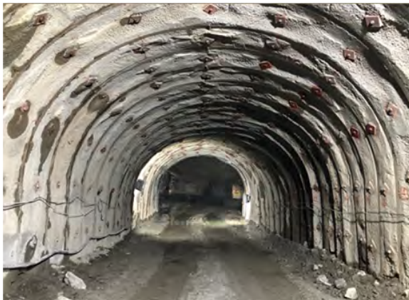
写真-4 避難連絡坑施工完了
