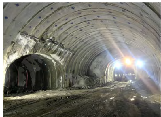
写真-6 避難連絡坑交差部
