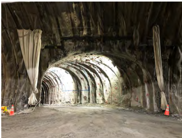
写真-5 本坑側から見た避難連絡坑
