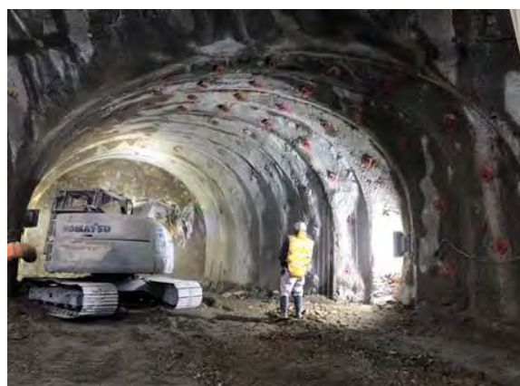
写真-2 避難連絡坑掘削状況
