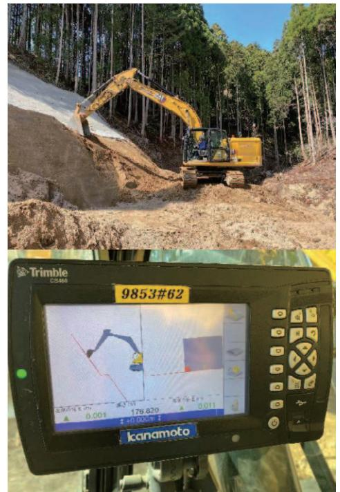
写真-7 MC建機施工状況
