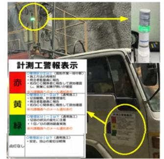
写真-7 切羽付近に設置の警告灯
