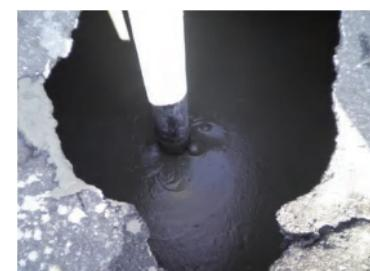
写真-21 充填状況(護岸空洞)
