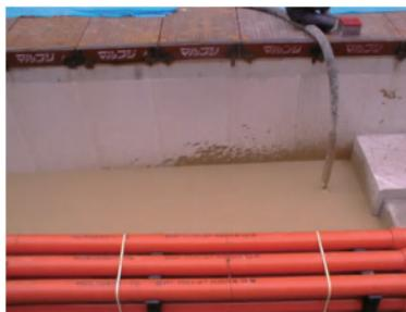
写真-8 埋戻し状況(交差点下) 写真-9 埋戻し状況(多条埋設管)
