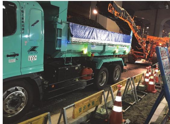
写真-5 舗装の切削廃材の積み込み状況
