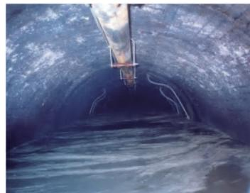
写真-22 プラント全景　写真-23 充填状況(トンネル閉塞)
