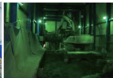
写真-17 LSS 製造(解泥状況)
