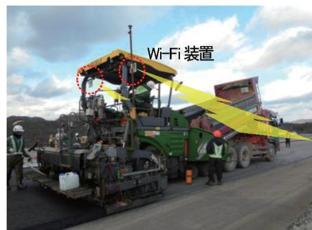
写真-3 Wi-Fi 装置 設置状況
