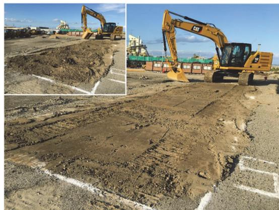
写真 5 チルトバケット施工
