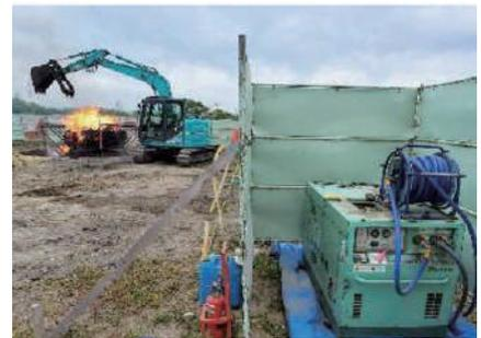
写真-6 圧縮空気を送るコンプレッサー
