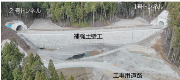
図-1 完成した瀬戸設楽線トンネル工事
