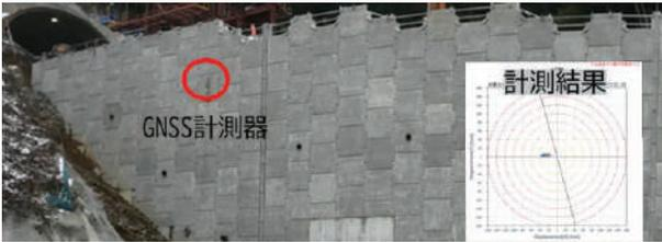
図-5 GNSSを用いた動態観測
