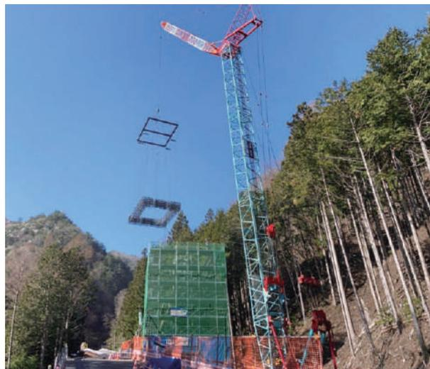
写真-5 地組鉄筋吊り込み状況写真
