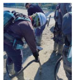
写真-3 コードレスバイブレータ
