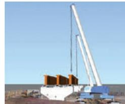
図-3 3Dモデルによる主桁架設シミュレーション
