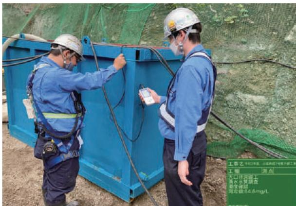
写真-3 処理設備と水質監視状況写真
