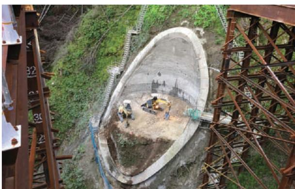
写真-4 竹割り土留工施工状況写真
