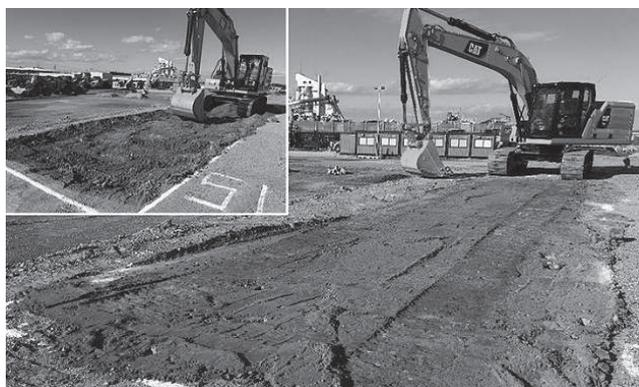
写真3 標準バケット施工
