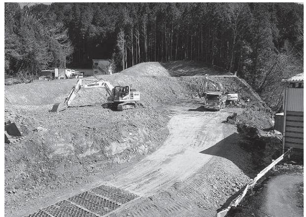
写真-4 ICT建機による掘削状況
