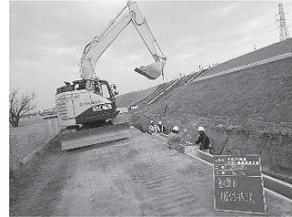
写真14 小旋回機械施工
