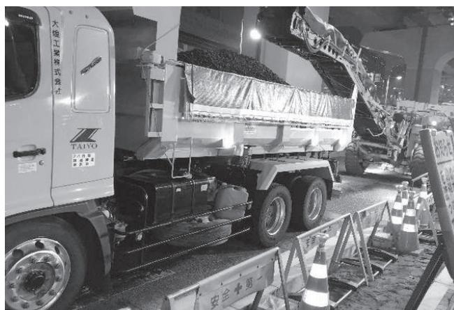
写真-5 舗装の切削廃材の積み込み状況
