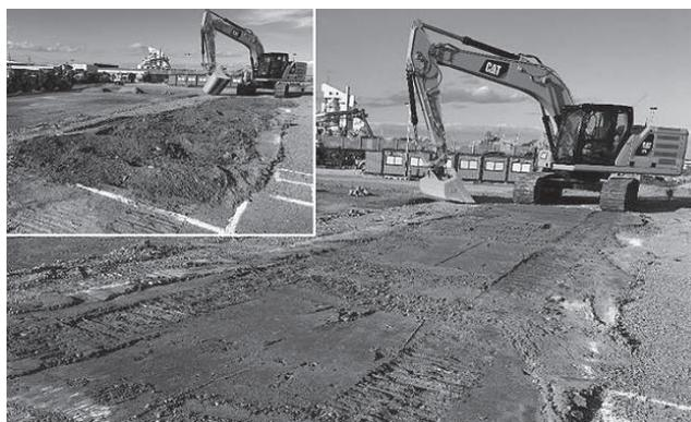
写真4 チルトバケット施工
