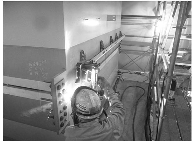
図-7 現場溶接施工状況
