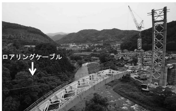
写真-3 ロアリング施工状況
