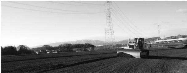
写真-3 MCブルドーザーによる施工状況
