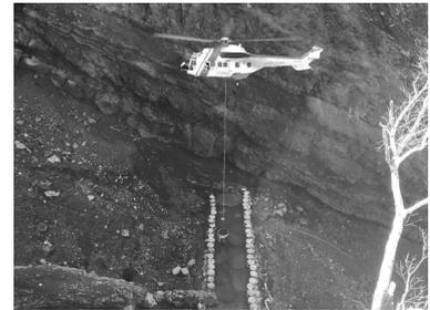
写真-5 大型土のう型枠据付状況・コンクリート打設状況
