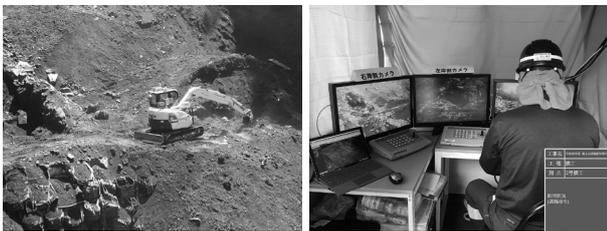
写真-3 遠隔操作による掘削状況・操作室
