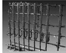
3次元点群データによる遠隔段階確認
