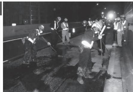
「ハードフレッシュ工法」は、コンクリート床版に生じた貫通ひび割れや微細なひび割れに深く浸透・接着する高浸透型防水材とアスファルト加熱型塗膜防水材の併用により、高い防水効果と補強効果が期待できる道路橋床版防水工法です。
