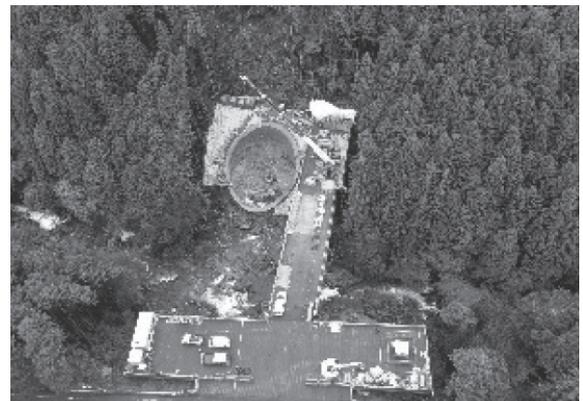
写真-2 竹割り型土留め施工状況
