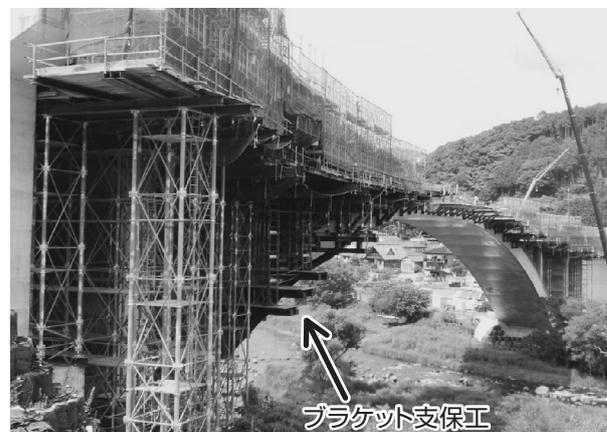
写真-5 補剛桁の支保工
