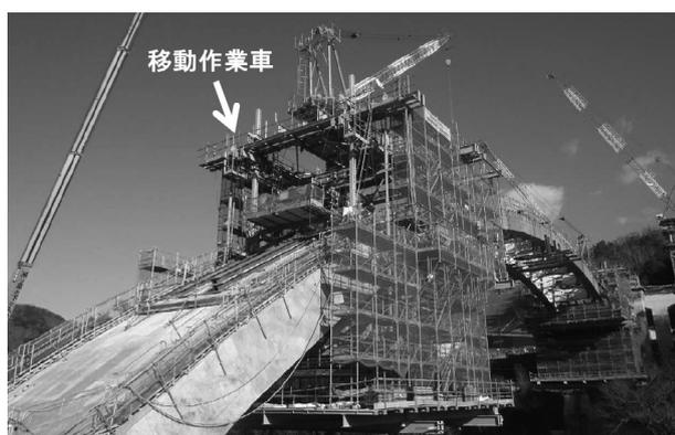
写真-4 移動作業車による巻き立て作業
