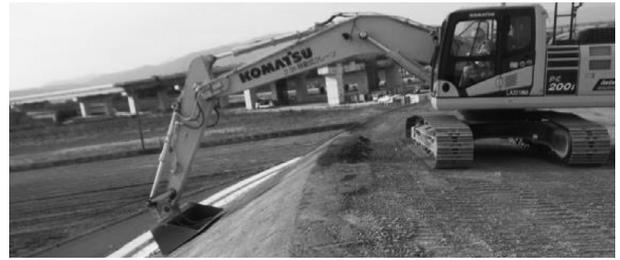
写真-5 MCバックホーによる施工状況
