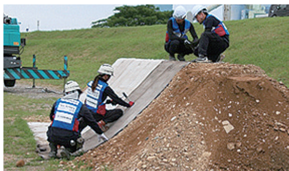
コンクリートキャンバスを用いた仮締切（浜松建設業協会）
