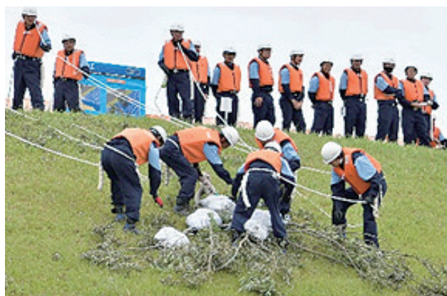
水防工法(木流し工)
