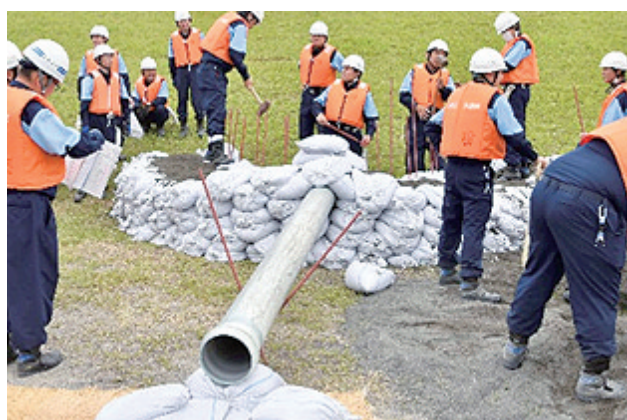
水防工法(釜築工)
