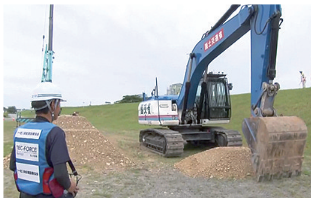
無人化施工バックホウによる仮締切(浜松建設業協会)
